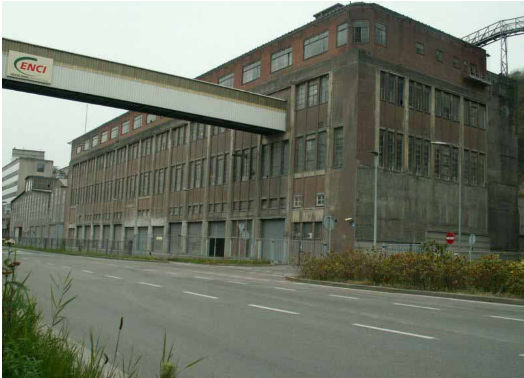
ENCI Cementfabriek, Maastricht
