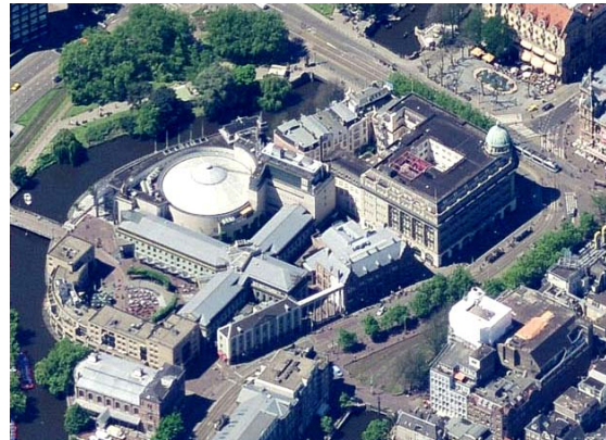
Luchtfoto huidige situatie:
